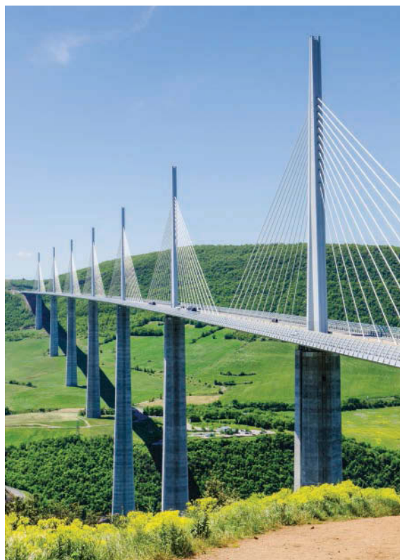
Le viaduc de Millau
